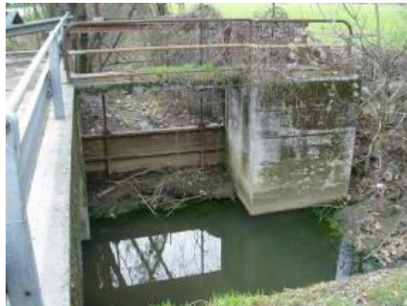
Figura 30: Sistema di chiuse in prossimità dell'abitato di Pozzuolo
