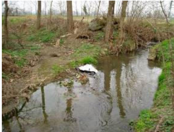
Figura 7: Punto nel quale il fontanile Cornice incontra una derivazione del torrente Trobbia, in prossimità della Cascina Piola
