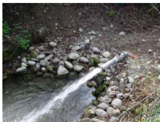
Figura 26: Sistema di pompaggio dell'acqua in corrispondenza della testata del fontanile
