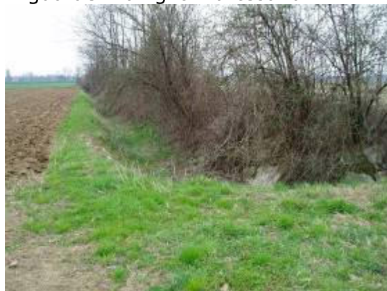
Figura 44: Particolare della Roggia Visconti in corrispondenza della Sp 103
