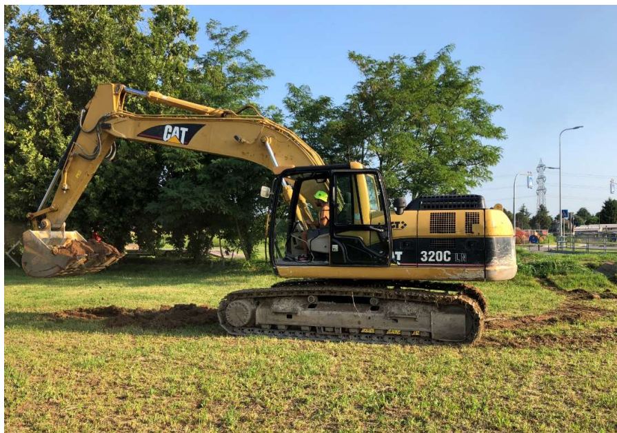
Figura 13 – Esecuzione Pozzetto n.2
