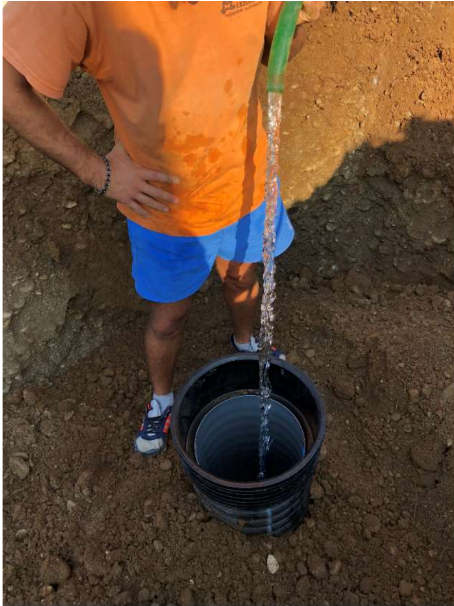
Figura 14 – Esecuzione prova di permeabilità
