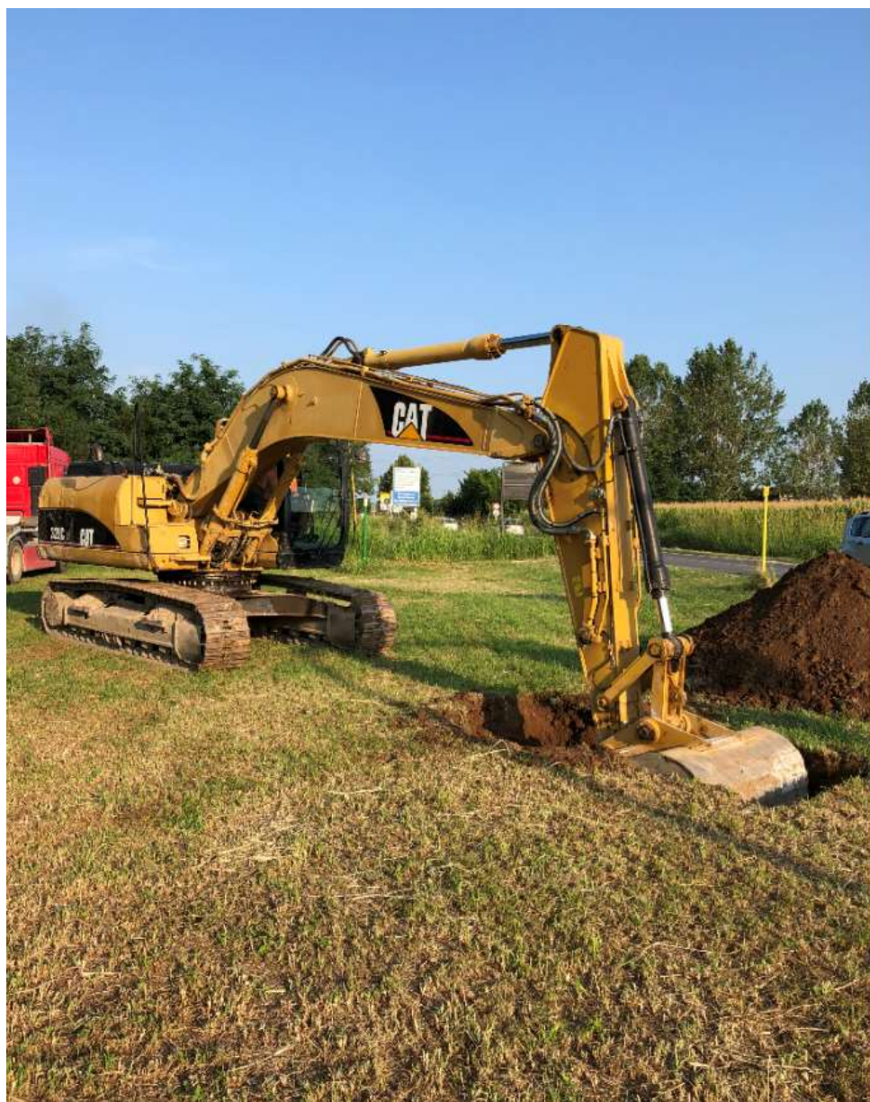
Figura 10 – Esecuzione pozzetto n.1
