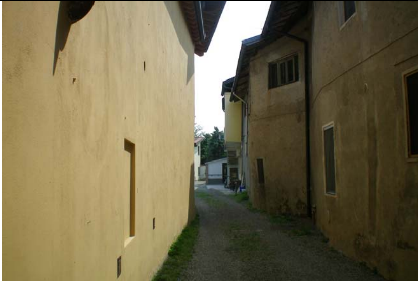
Ambito A : accesso alla corte dell'ambito A da via G. Garibaldi
