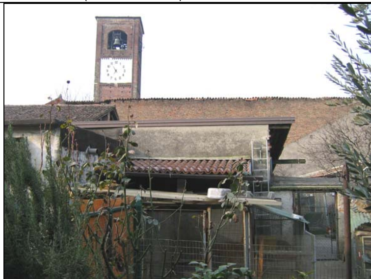
Ambito G: vista corte interna (cono ottico foto 20)
