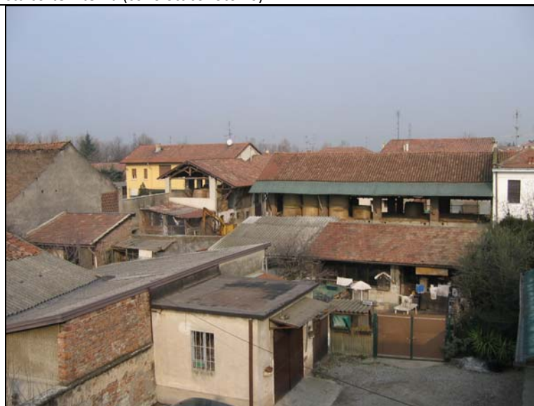
Ambito G: vista corte interna (cono ottico foto 12)
