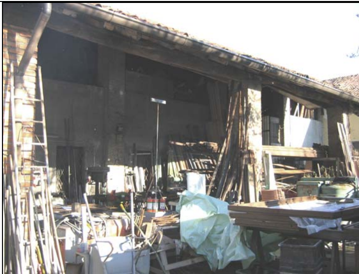
Ambito G: vista corte interna (cono ottico foto 27)
