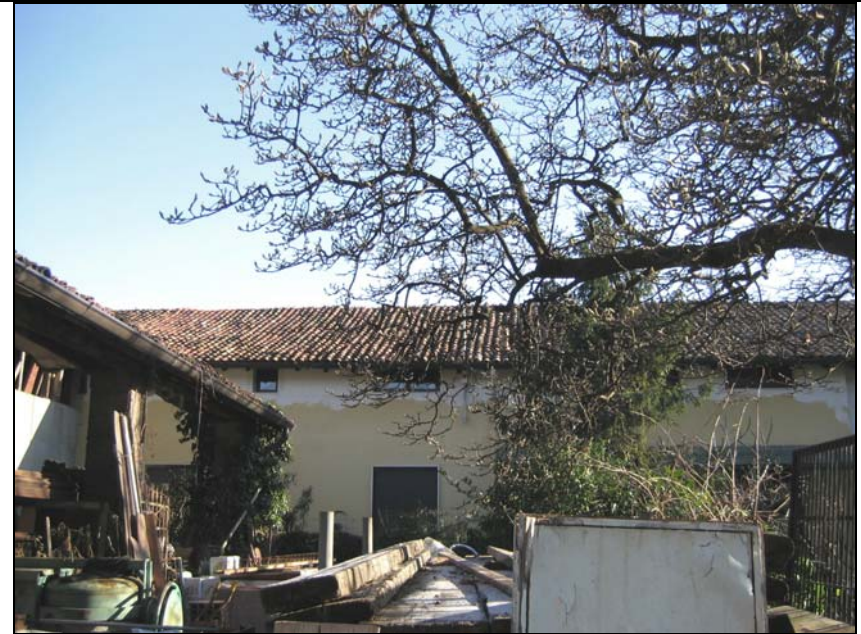
Ambito G: vista corte interna (cono ottico foto 26)
