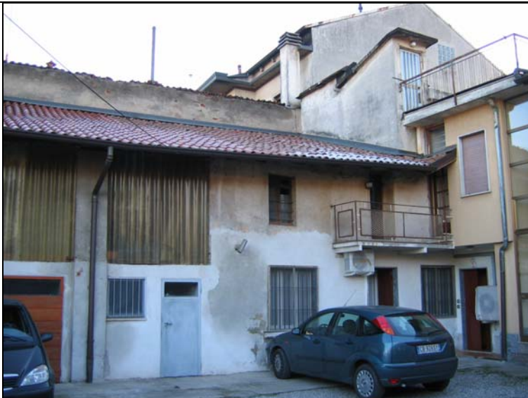
Ambito G: vista corte interna (cono ottico foto 16)
