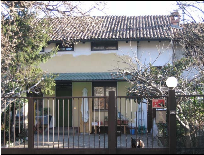
Ambito G: vista corte interna (cono ottico foto 25)
