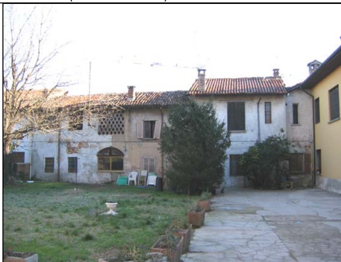
Ambito G: vista corte interna (cono ottico foto 23)
