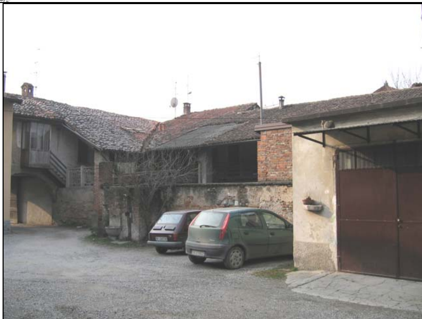
Ambito G: vista corte interna (cono ottico foto 18)
