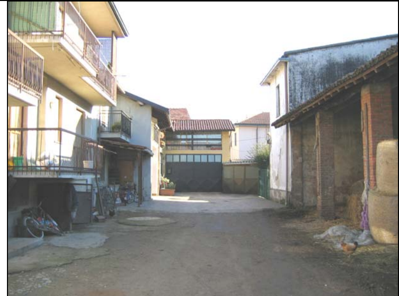
Ambito B: vista del cortile interno mapp. 79N – 81 (cono ottico foto 6)
