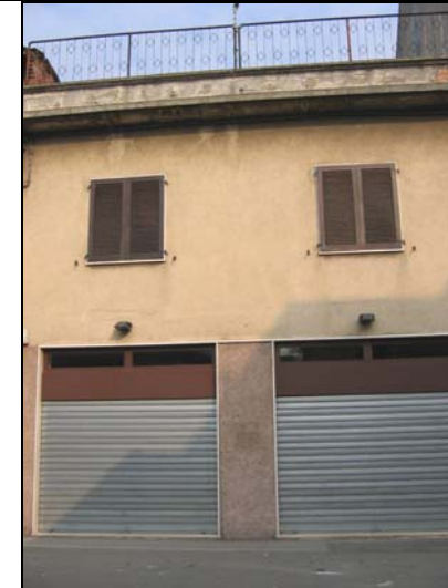
Ambito G: vista corte interna (cono ottico foto 2)
