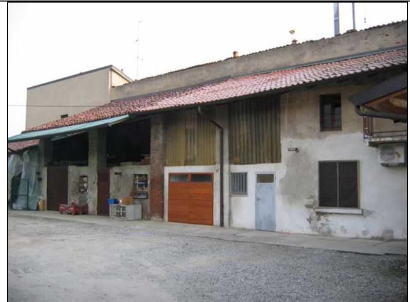
Ambito G: vista corte interna (cono ottico foto 15)
