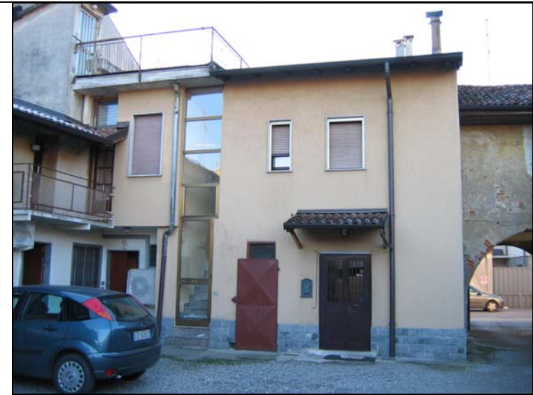
Ambito G: vista corte interna (cono ottico foto 17)
