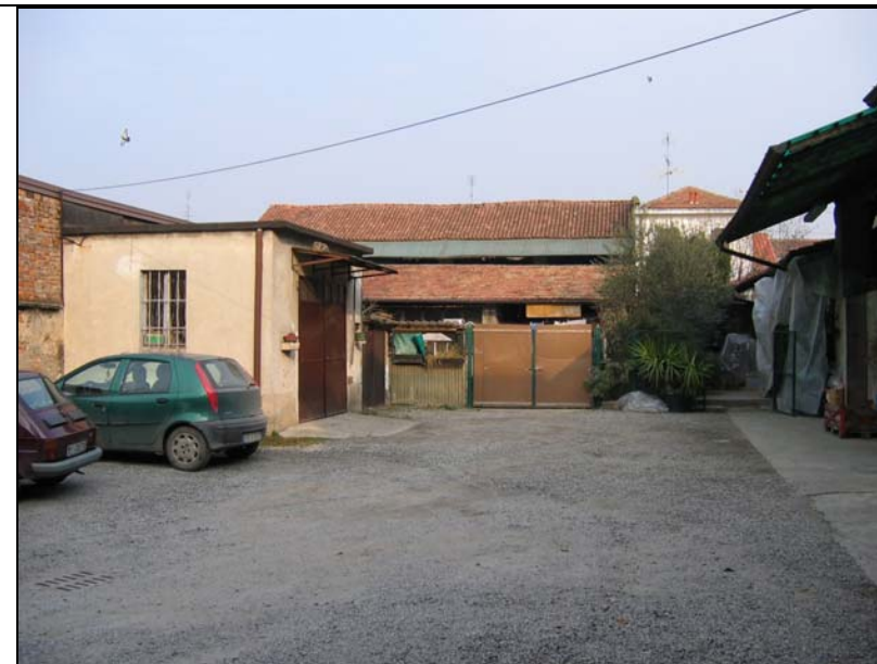
Ambito G: vista corte interna (cono ottico foto 19)
